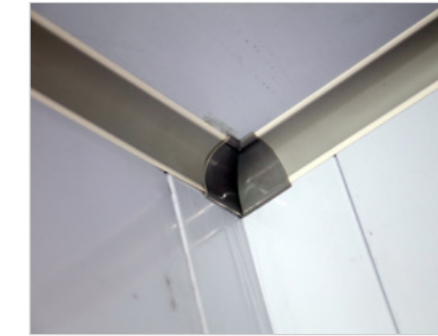
ANGOLO INTERNO ARROTONDATO INSIDE ROUNDED CORNER
